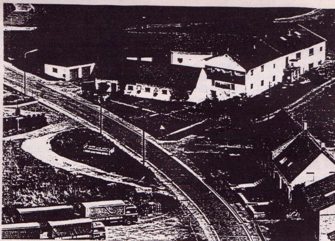
Das Mühlrad befand sich an der rechten Gebäudeseite in vorderen Bereich (urspr. Waldmühle). Die hinteren und seitlichen Gebäudeteile sind erst später gebaut worden.
